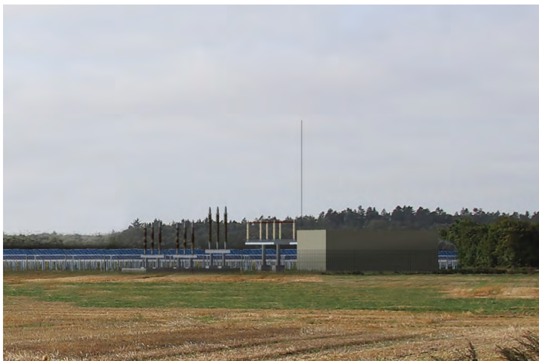
Figur 2.3: Eksempelvisualisering af step-up transformer med tilhørende 20 meter høj lynafleder og trådhegn. Illustrationen viser step-up transformeranlægget uden den afskærmende beplantning for tydeligere at kunne illustrere transformeranlæggets elementer.
