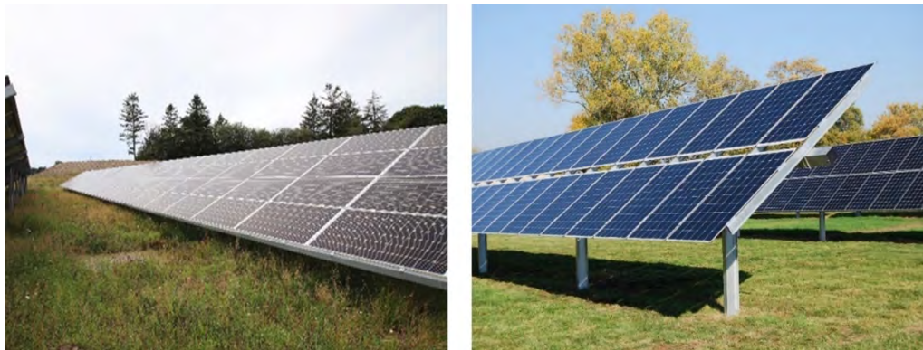
Figur 2.1: Solceller monteret på faste stativer (til venstre) og på bevægelige stativer, kaldt trackersystem (til højre).
